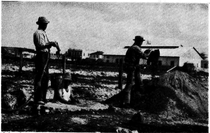
Labor de desobstrucción que realizan los obreros de Obras Públicas en los registros de los grandes drenes pluviales de las calles 10 y 6, entre tercera y el mar, en el Vedado. La limpieza de estos drenes que muestran las fotos no ha terminado aún, y puede observarse, empero, la considerable cantidad de arena extraída.
